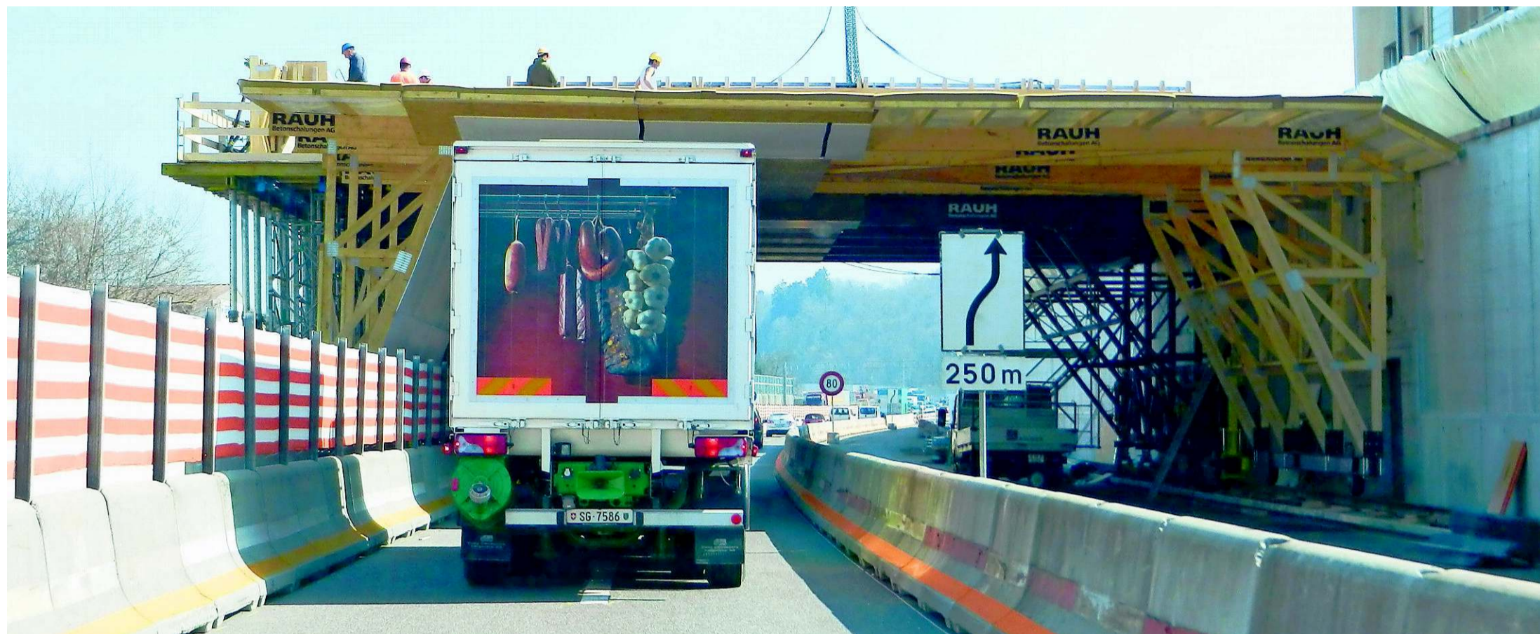
Baustelle für die Halbüberdeckung der A1 in Lenzburg: Hier wird die Durchfahrt auch für jene Lastwagen knapp, welche die erlaubte Höhe von 4 Metern einhalten.
