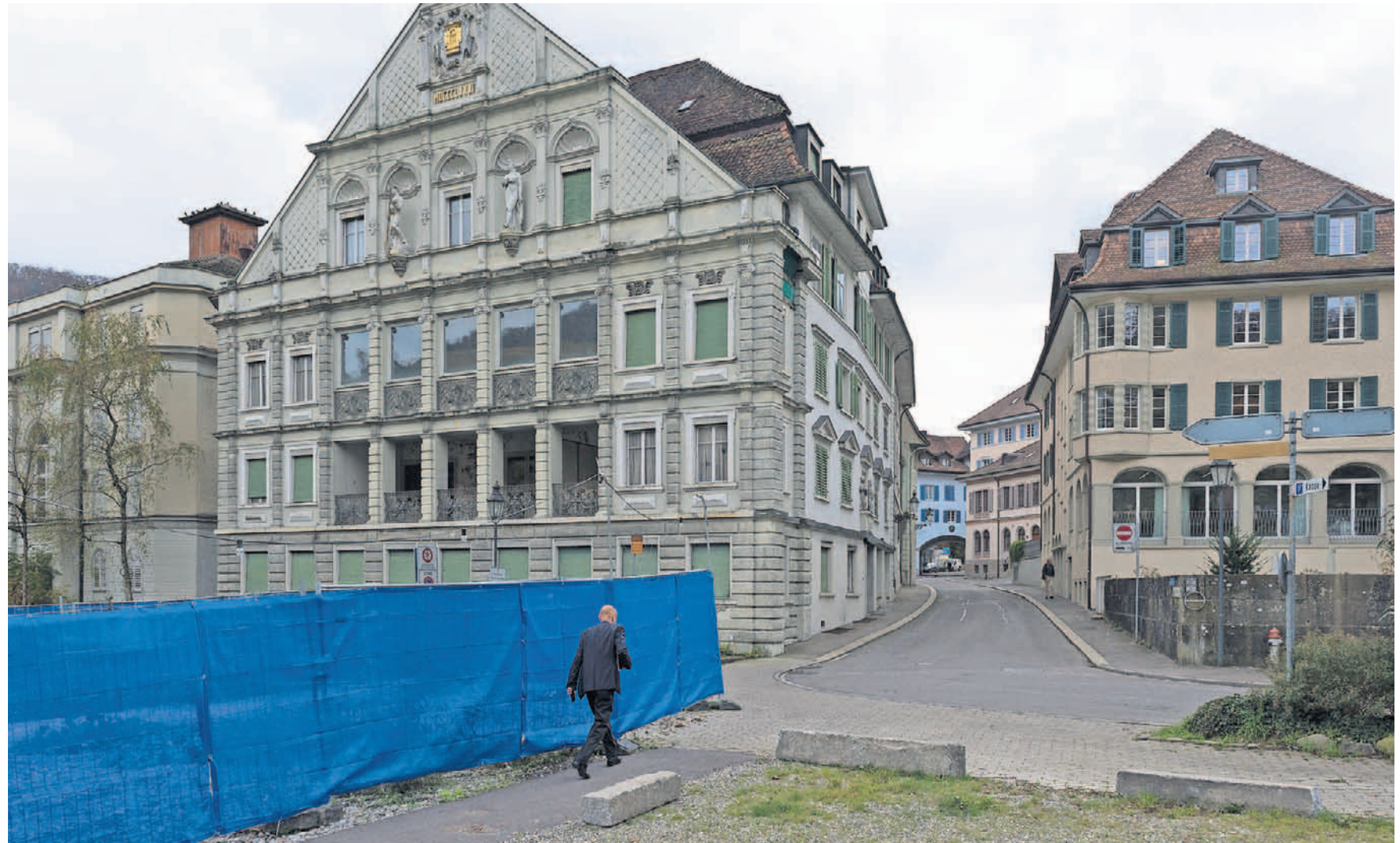
Blick vorbei an der Grabungsstelle, hindurch zwischen der renovierten Dépendance Bären (rechts) und dem abbruchreifen Hotel Bären (links).
