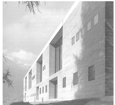
Fassade ausserhalb Erdreich
